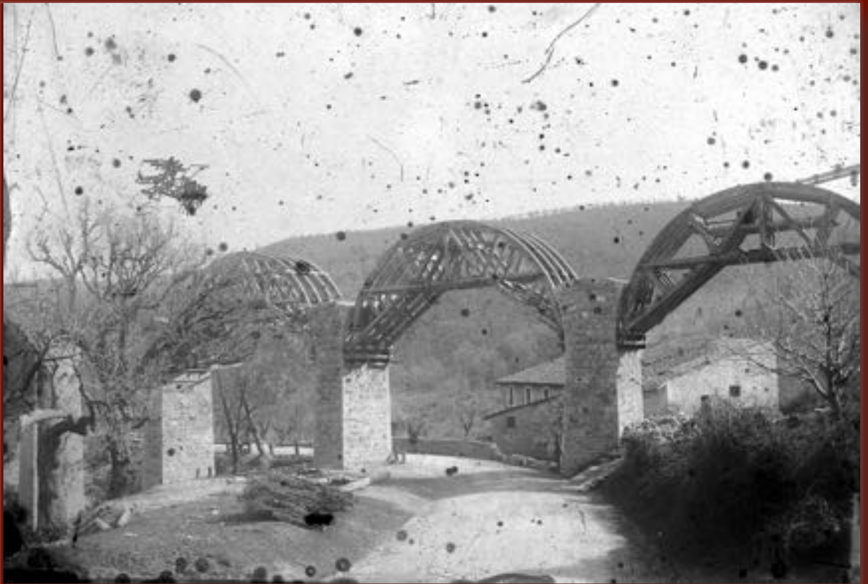
Caprareccia, montaggio centine sui piloni. Lastre fotografiche di Paolo Basler, foto 1917. Spoleto, Sezione Archivio Stato, Archivio Paolo Basler
