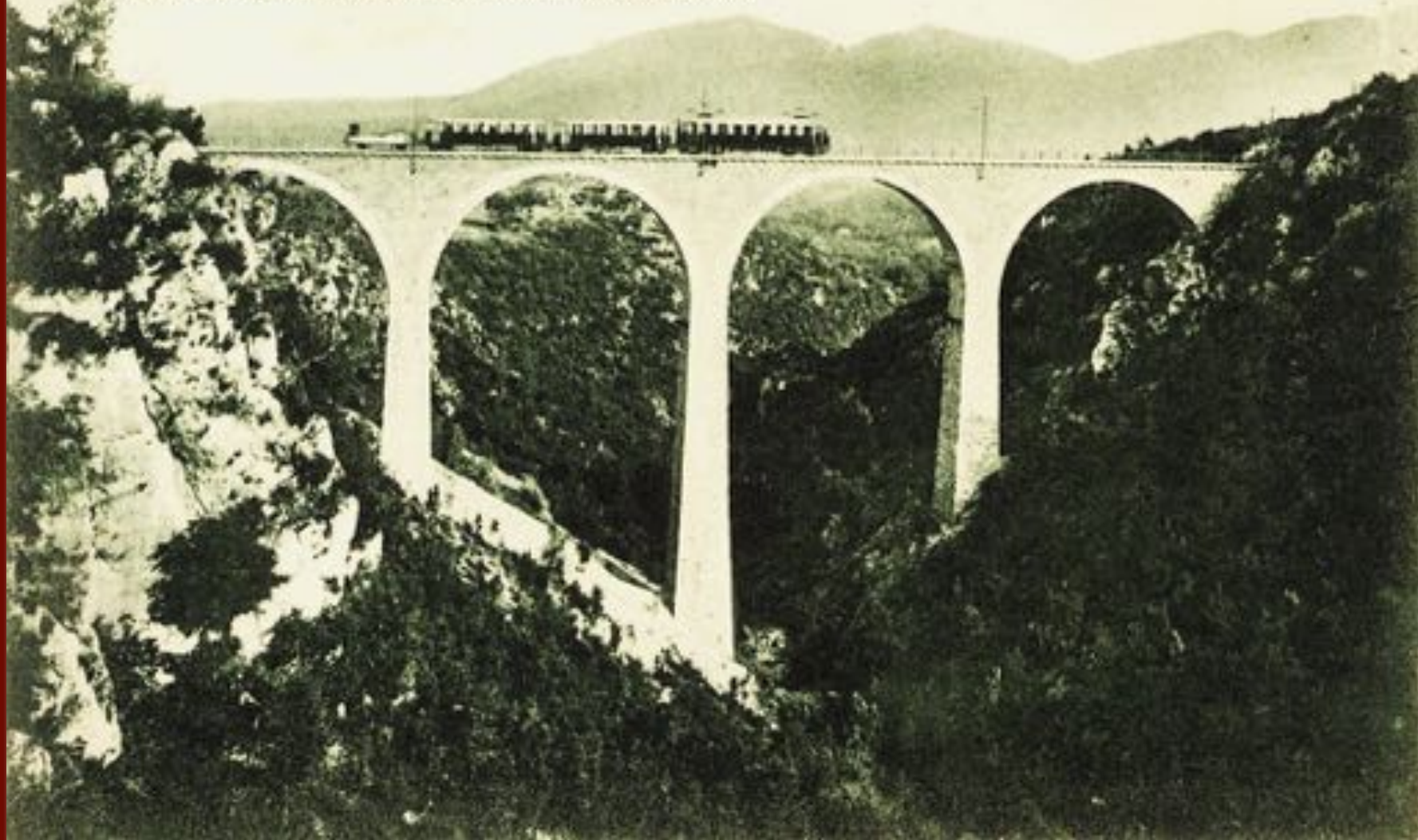
Ferrovia Spoleto-Norcia - Viadotto di Cortaccione
