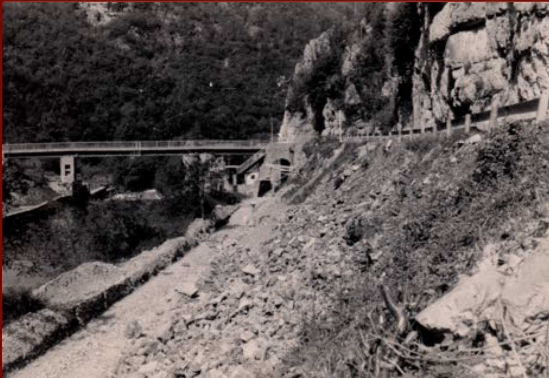
La ferrovia lungo il Corno all'altezza di Nortosce, lavori di allargamento della strada. Foto anni '70 del '900. Spoleto, Collezione G. Farinelli
