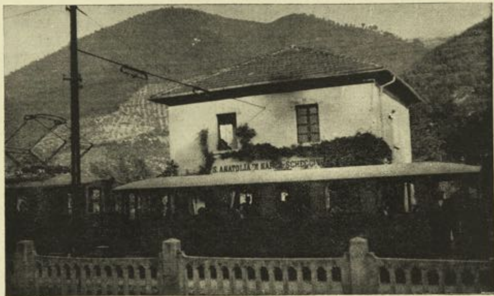
SANT'ANATOLIA DI NARCO - Stazione ferroviaria
