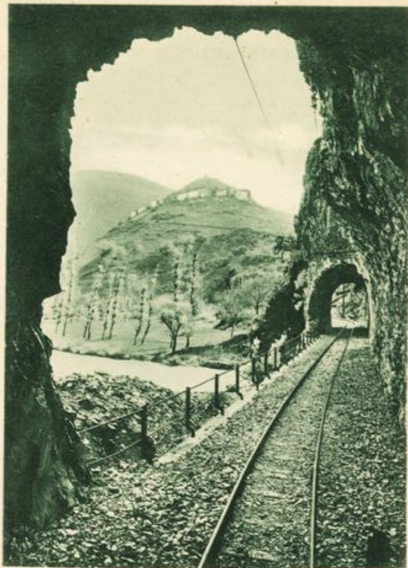
Ferrovia Spoleto-Norcia - Galleria Le Lastre al Km. 30 con la veduta di Ponte in Val di Nera
