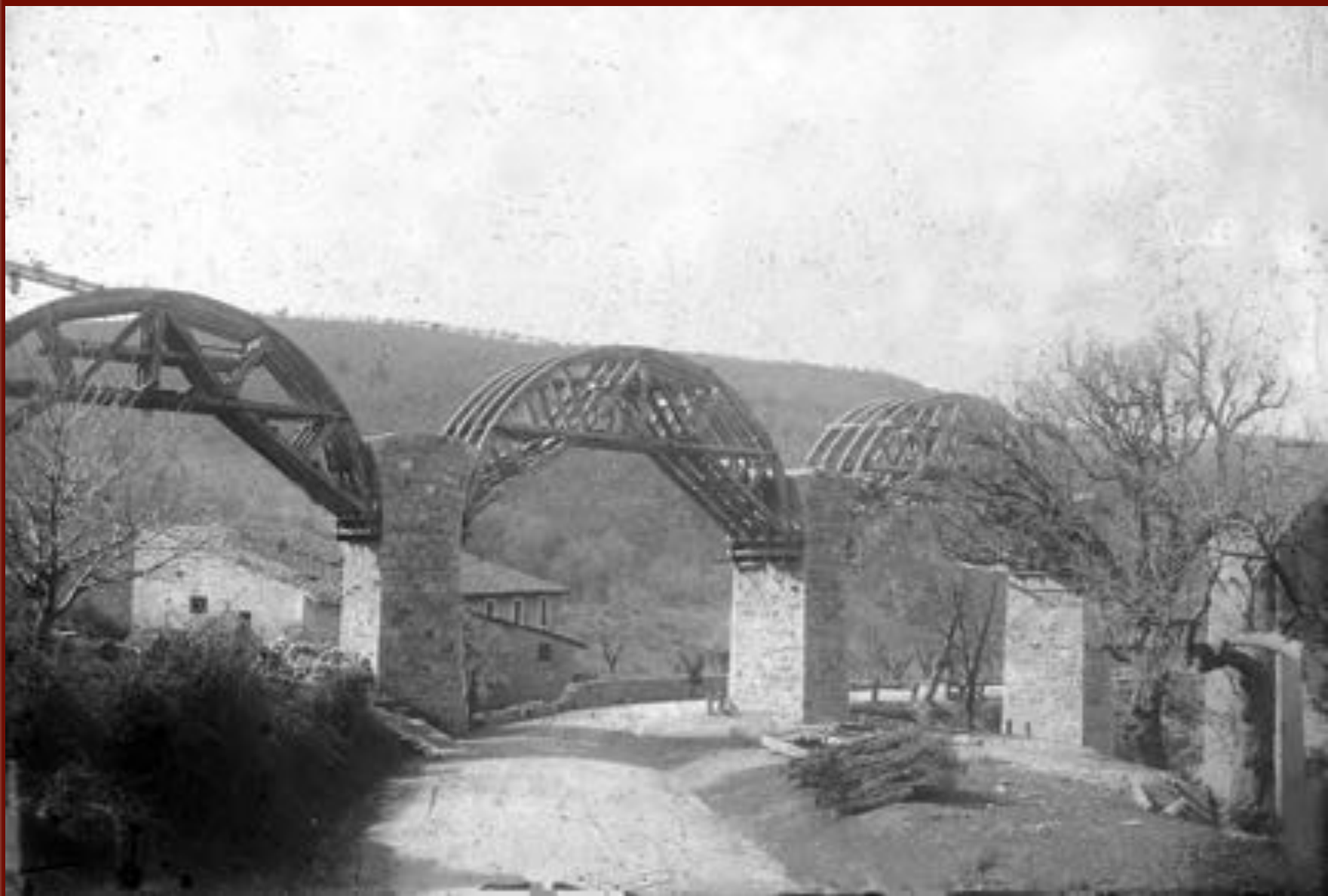
Caprareccia, montaggio centine sui piloni. Lastre fotografiche di Paolo Basler, foto 1917. Spoleto, Sezione Archivio di Stato, Archivio Paolo Basler
