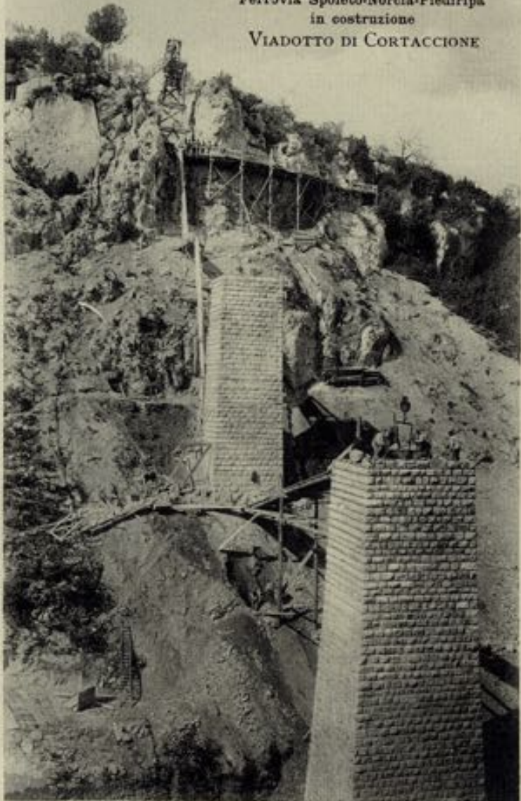
Pila N. 1 e 2 in costruzione
