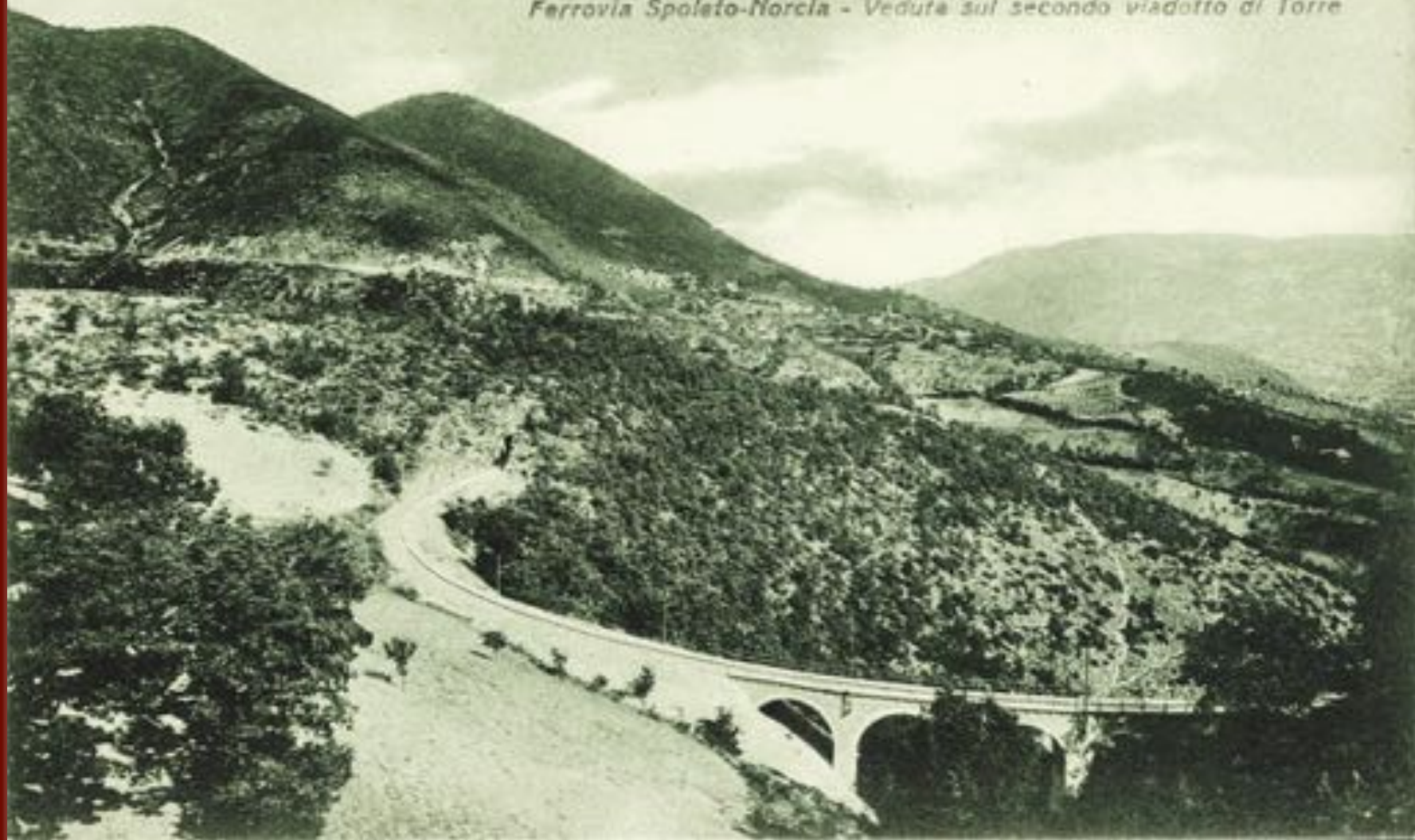
Ferrovia Spoleto-Norcia - Veduta sul secondo viadotto di Torre
