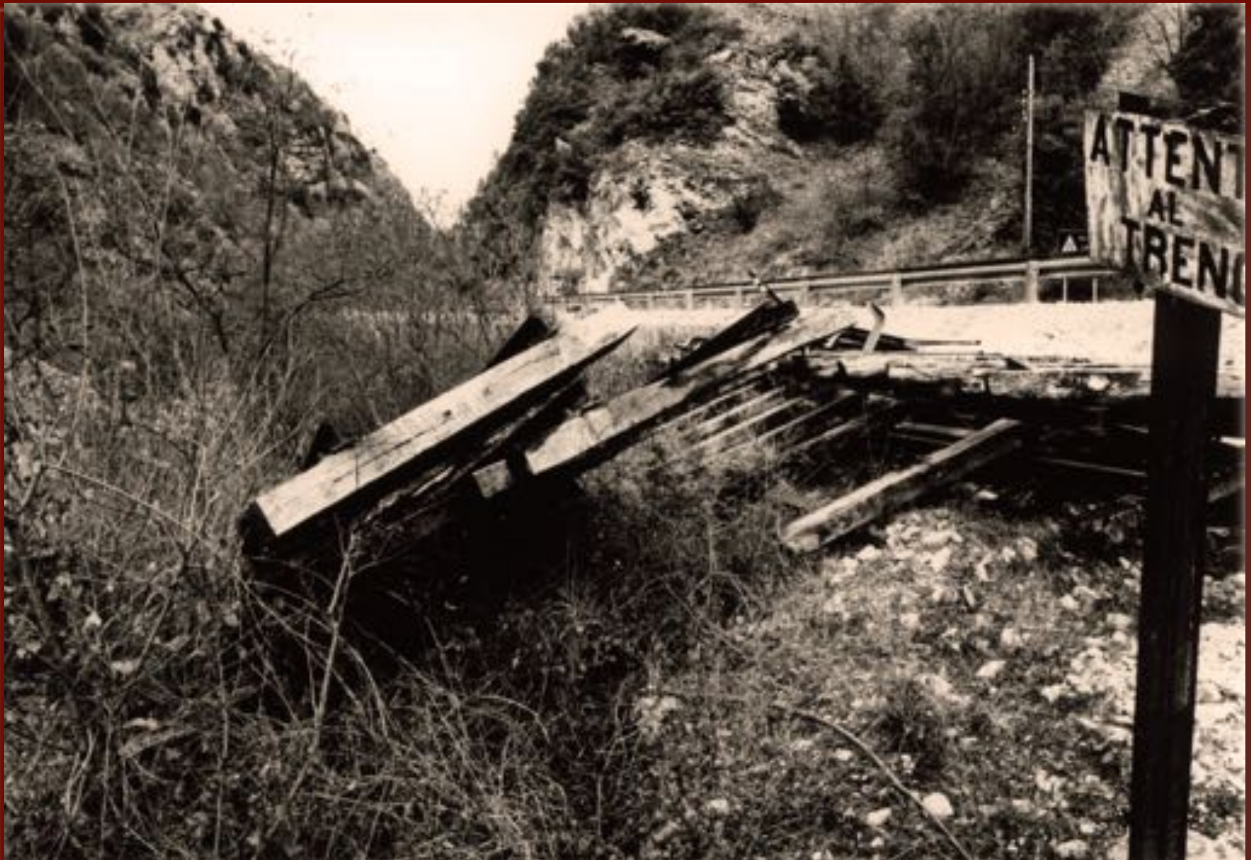
La ferrovia (km 39) lungo la statale in prossimità di Biselli, lavori di smantellamento di rotaie e traverse. Foto anni '72 del '900. Spoleto, Collezione G. Farinelli
